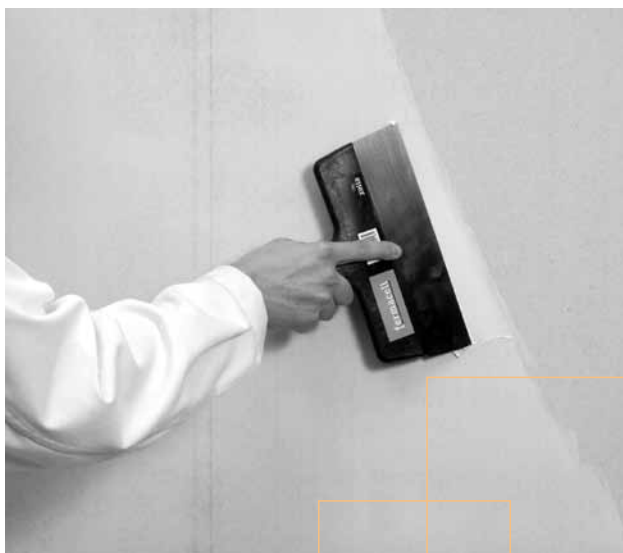
Plošné stěrkování sádrovláknitých desek FERMACELL
