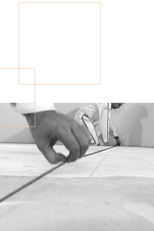
Vyznačení osy stěny provázkem nebo stavebním laserem
