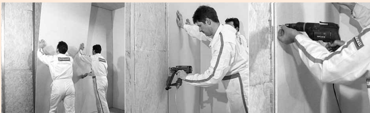
Opláštění kovové spodní konstrukce
