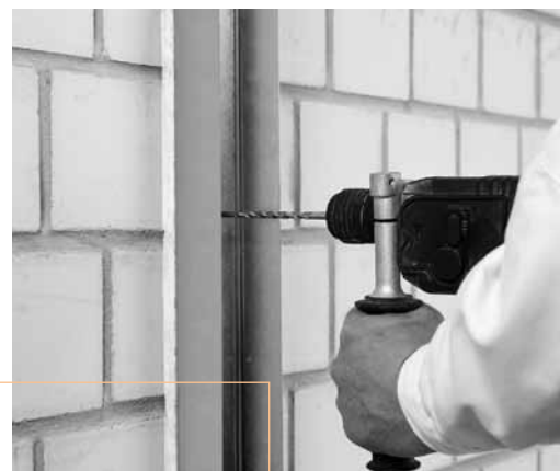
Upevnění CW profilu na masivní stěnu s izolační páskou
