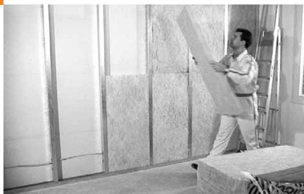
Vkládání izolačních desek z minerálních vláken
