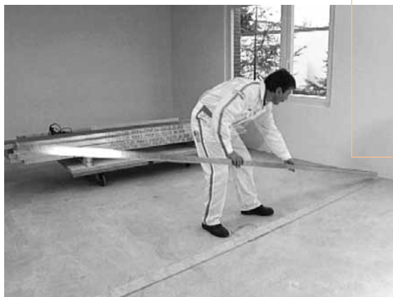
Upevnění vodícího UW profilu na izolační pásku na podlaze
