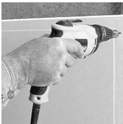
Šroubování na kovovou spodní konstrukci
