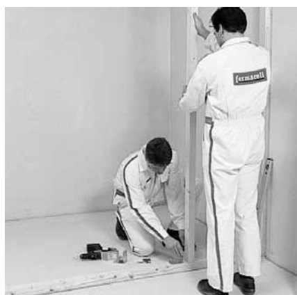
Montáž spodní konstrukce hmoždinkami nebo kovovými úhelníky
