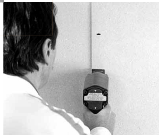
Upevňování desek FERMACELL na desky FERMACELL sponkami
