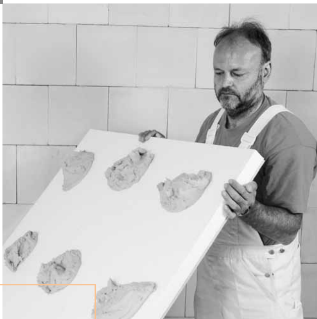
Spojené desky FERMACELL Rozměry: 150 x 100 cm = 1,5 m 2 10 mm FERMACELL plus izolant
