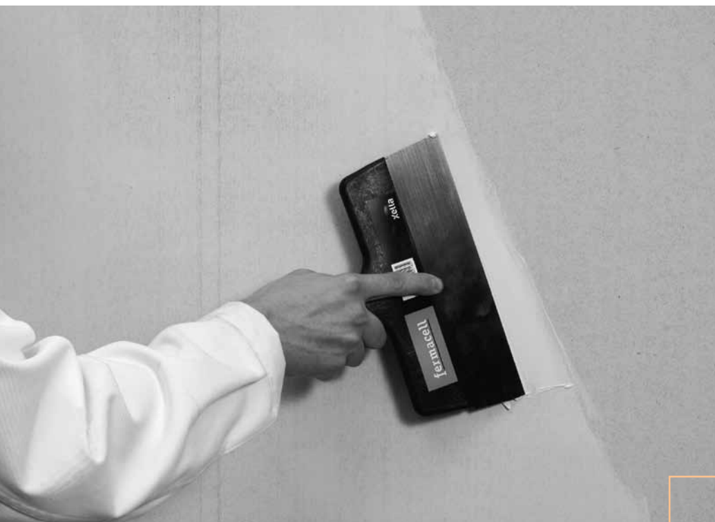
Stěrkování sádrovláknitých desek FERMACELL
